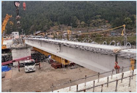
5 セグメント接合桁架設
