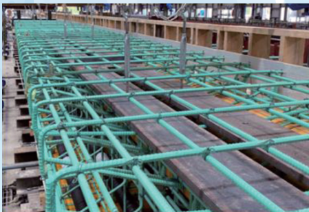
圧縮側 鋼板配置状況
