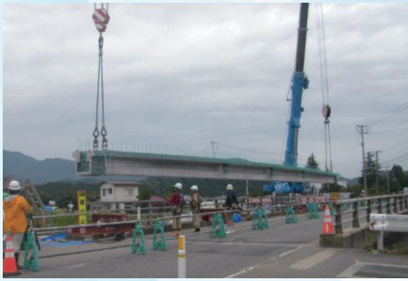
3 セグメント接合桁架設
