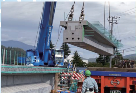
セグメント桁荷卸し
