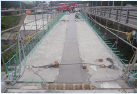
桁間コンクリート打設後
