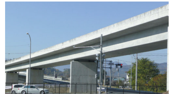
皆野橋(埼玉県)外ケーブル併用連続箱桁橋
