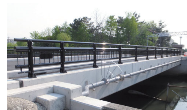
吾妻大橋（千葉県）プレテンション中空床版桁橋 (φ15.2mmSC-S及び塗装鉄筋採用)
