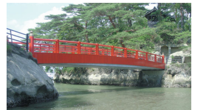
渡月橋（宮城県）プレテンション中空床版桁橋 (φ15.2mmSC-S及び塗装鉄筋採用)
